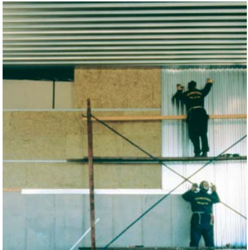
rys. 5 Ściana osłonowa, jako lekka obudowa hal, z blachy profilowanej w układzie pionowym
