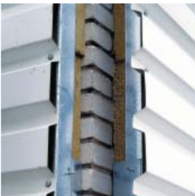
rys. 4 Szczegóły ocieplenia ściany i obróbki blacharskie przy otworze okiennym
